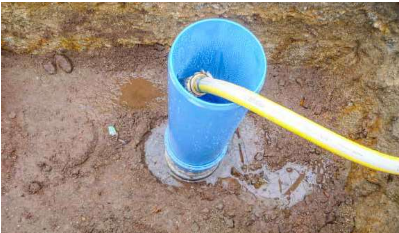
Abb. 5: Feldversuch zur Bewässerung des Wurzelgrabens über ein Belüftungsrohr
