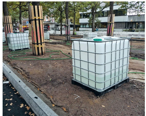
Abbildung 10: IBC-Container mit Tröpfchenbewässerungsschläuchen zur vorübergehenden Bewässerung während einer Baumaßnahme
